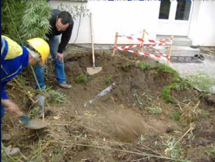
Excavations manuelles vis-à-vis des réseaux
