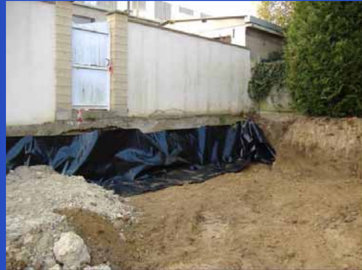
Pose de géomembrane en bordure non excavée
