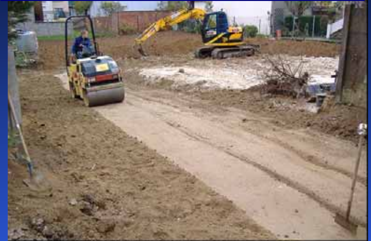
Travaux de Remblaiement avec des terres saines rapportées
