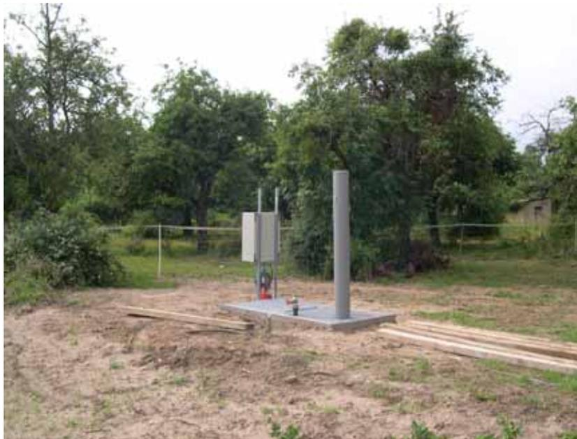
**Traitement des eaux pompées par hydroéjecteur (60-70% d'efficacité) avant rejet des eaux au milieu naturel.**
