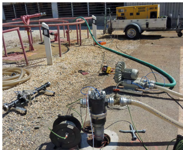
Ligne d'extraction en place sur un ouvrage existant.
