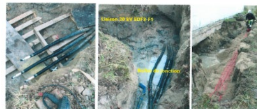
COUPURE CABLES, JONCTION ET REBOUCHAGE TRANCHEE
